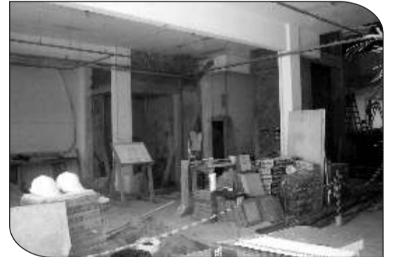
Obras no piso térreo e sobreloja da SRTE/SC
